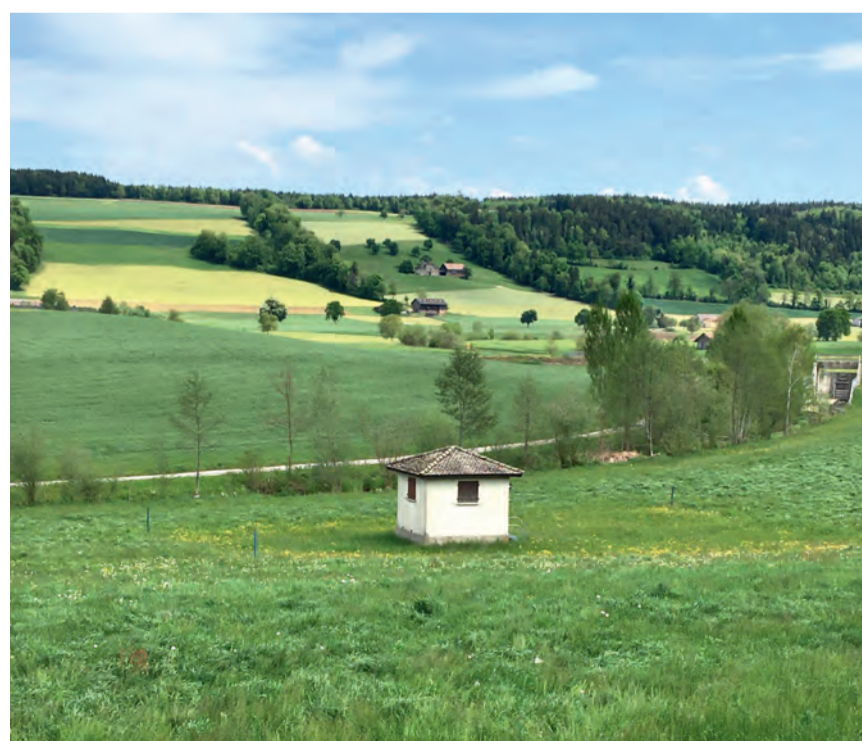
Grundwasserfassung und Pumpwerk Eichmatt.
